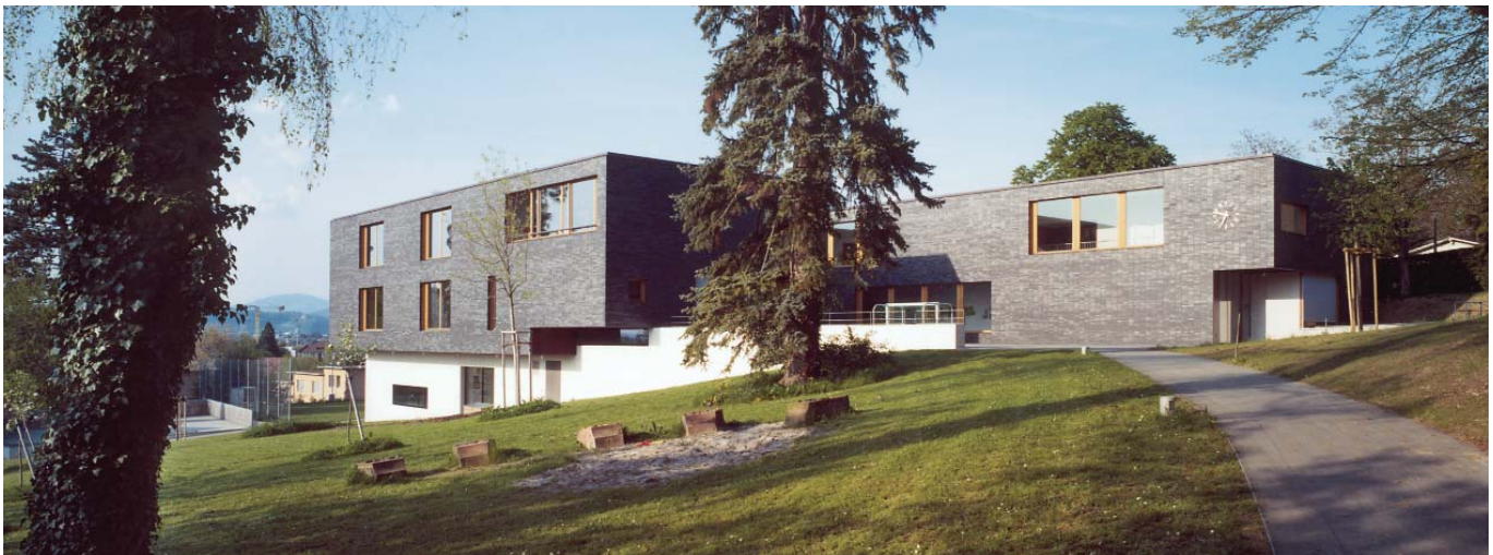
SCHULHAUS / TURNHALLE, SÜDWESTANSICHT
