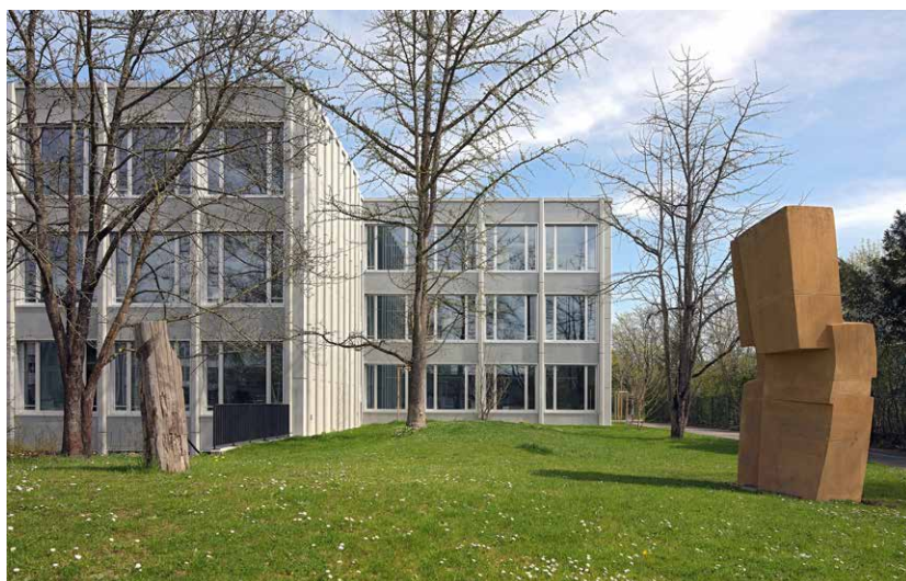
Architektur und Kunst in park-ähnlicher Umgebung: Schultrakt des Gymnasiums Bäumlhof mit erneuerter Fassade
