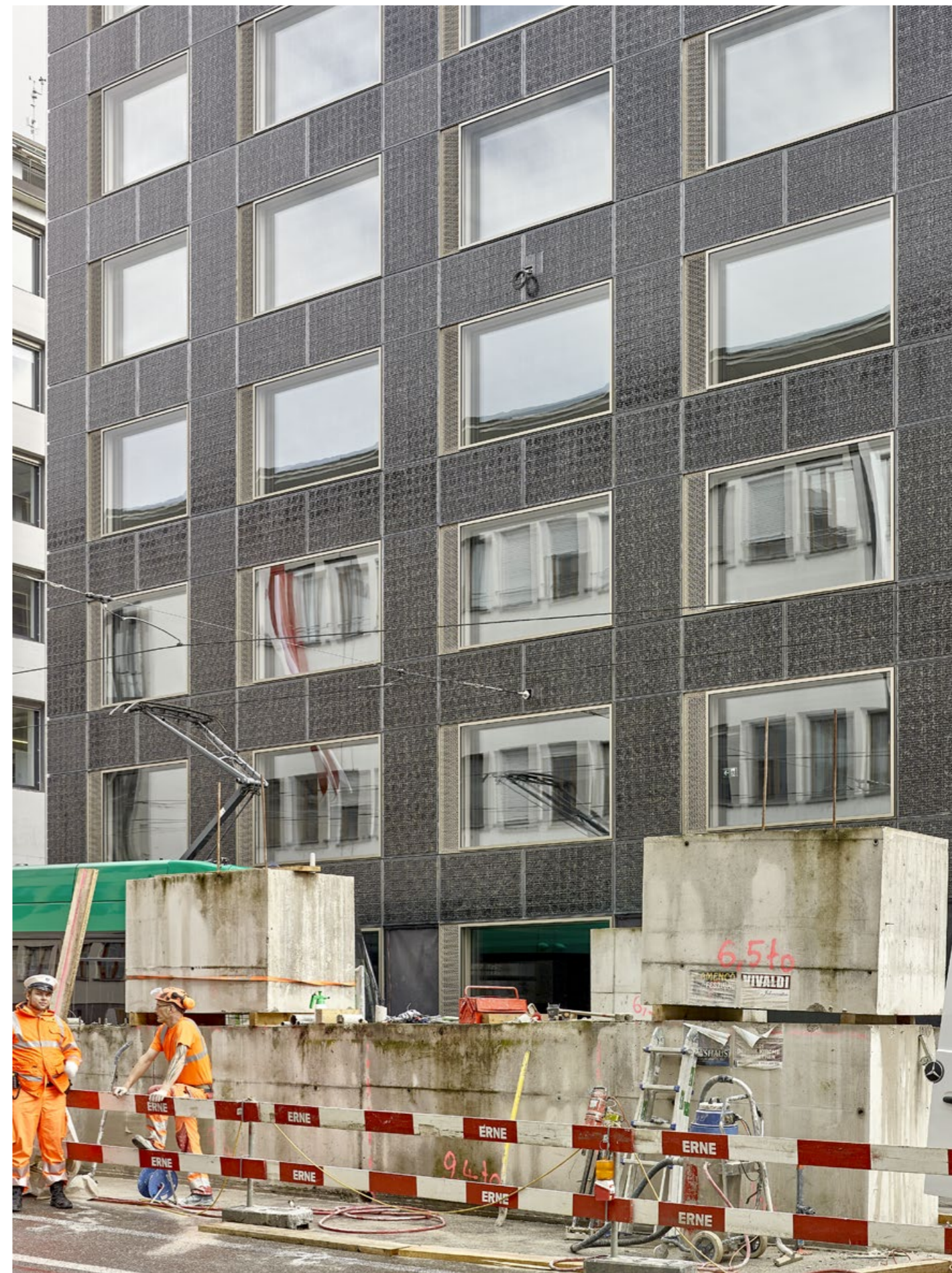
3 Spiegelgasse: Am 1. November 2021 nimmt das AUE seinen Betrieb am neuen Standort auf.
